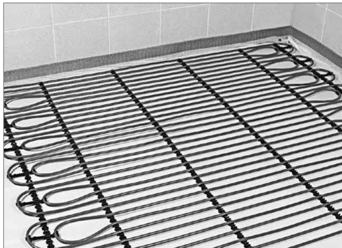
Рис. 21-67 Напольная фиксирующая шина для «мокрого» способа монтажа
